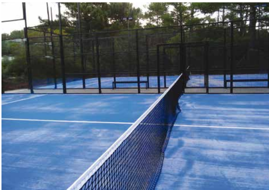
La surface sportive est un gazon synthétique très dense de 12 mm d'épaisseur, de couleur bleue, peu chargée en sable permettant d'avoir moins de matière retenue dans la surface.
