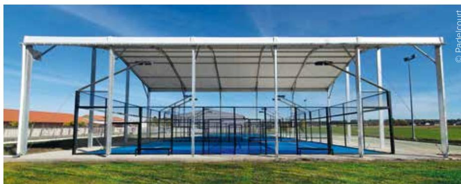
L'un des trois courts de padel dispose d'une structure semi-couverte en aluminium et d'une toile tendue afin de laisser passer un maximum de lumière naturelle.
