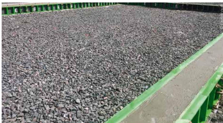
Les longrines en béton fibré installées en périphérie de chaque terrain garantissent l'ancrage des poteaux de la structure et servent de coffrage au béton alvéolaire.
