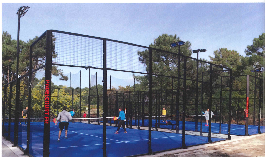
La structure est ancrée au sol par vissage avec des goujons à expansion dans des longrines périphériques en béton fibré de dimensions 0,40 x 0,40 x 61,60 m.
